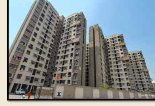
चहोली प्रकल्प - १,४४२ घरे एकूण खर्च: ₹१६९.४३ कोटी प्रकल्प पूर्णता: जुलै २०२४
